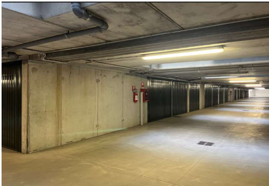
10 - corsello comune di manovra vani autorimessa
